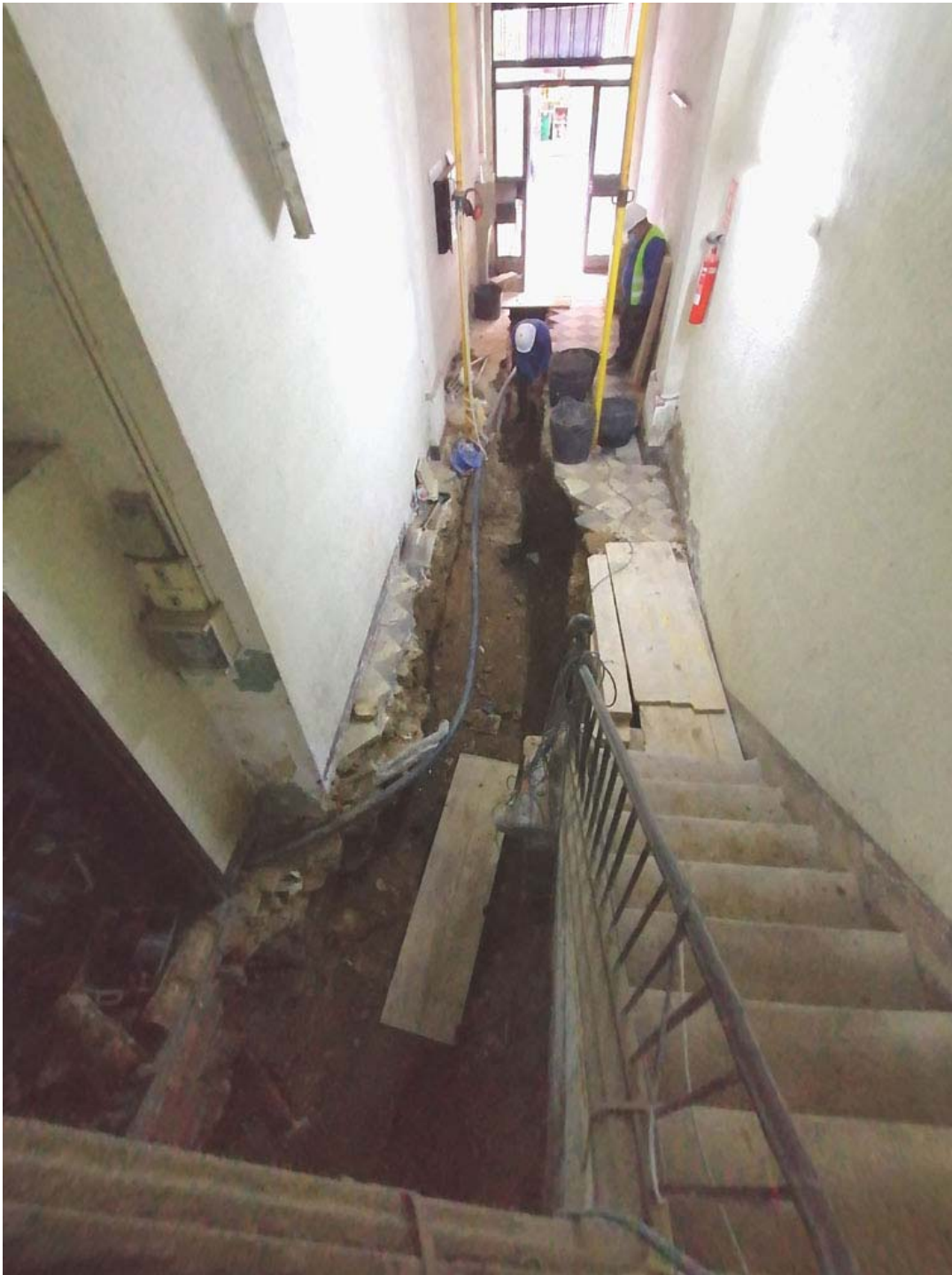
FOTOGRAFIA 9 → Panoràmica aèria de la zona del vestíbul d'entrada a la finca, durant les tasques d'obertura de la rasa longitudinal per la instal·lació de la canalització de les aigües residuals, des de l'oest.
