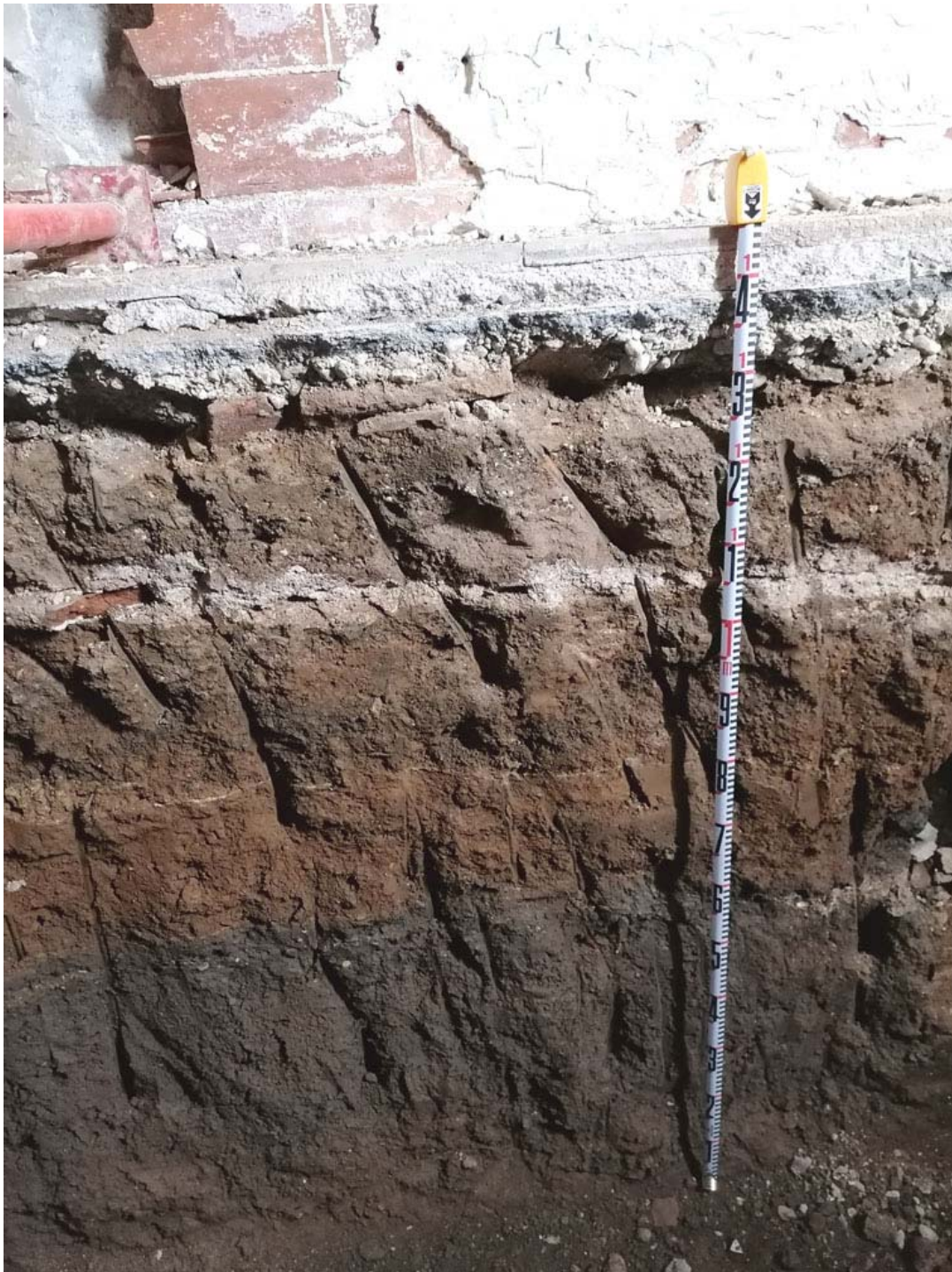
FOTOGRAFIA 6 → Fotografia de detall de l'estratigrafia localitzada al forat de l'ascensor, des de l'est.
