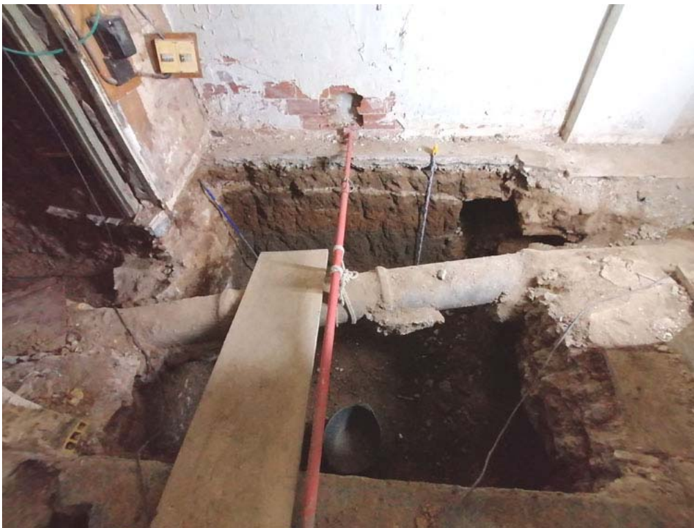
FOTOGRAFIA 5 → Vista final de la cala oberta per fer el fossat de l'ascensor, des de l'est.
