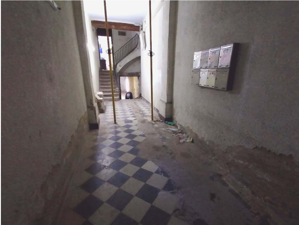
FOTOGRAFIA 7 → Imatge inicial del vestíbul d'entrada als pisos de la finca del carrer Nou de la Rambla, 16, on es va obrir la rasa per l'evacuació de les aigües residuals, des del sud.
