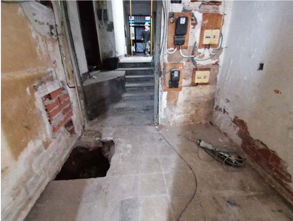
FOTOGRAFIA 2 → Imatge inicial de la zona de la planta baixa, al final del vestíbul, on es va obrir el forat per l'ascensor, des del nord.
