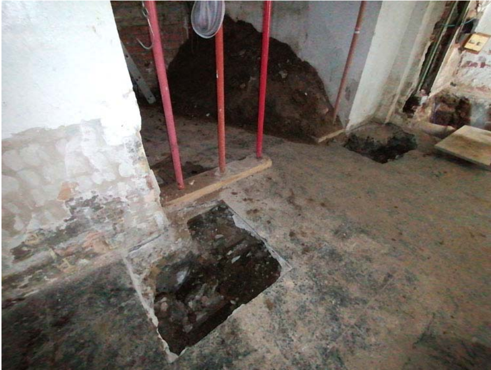
FOTOGRAFIA 13 → Fotografia de les dues cales de comprovació de la fonamentació obertes al local dels baixos de l'edifici, des del nord-est.
