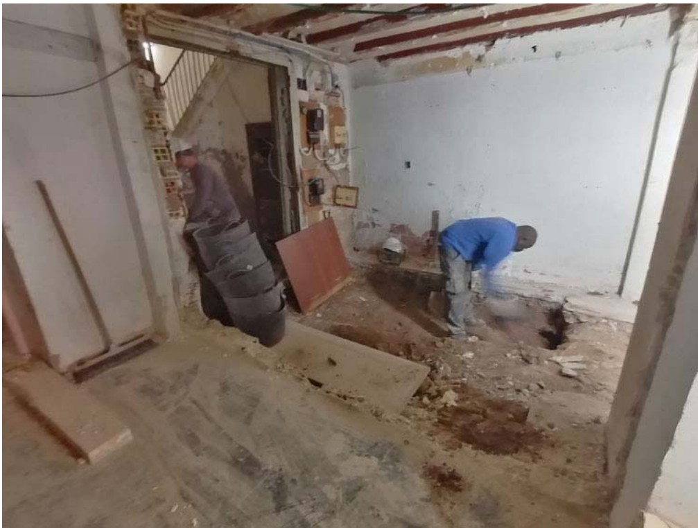
FOTOGRAFIA 3 → Vista de les tasques inicials d'obertura de la cala per construir el fossat de l'ascensor, des del nord-est.
